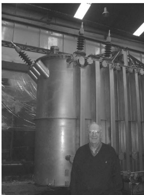
Luis Cervetto, titular de LOS CONCE frente a un transformador de alta potencia en reparación.
